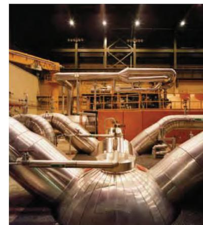
estado líquido en el condensador, retornando, mediante el concurso de las bombas de condensado y de agua de alimentación, al generador de vapor para reiniciar el ciclo. En esta fase se incorporan varios procesos de precalentamiento para optimizar el rendimiento termodinámico. Asimismo, se dispone de un depósito de agua de alimentación para mejorar la disponibilidad del sistema.
