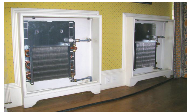
■ Radiadores instalados en el proyecto.
