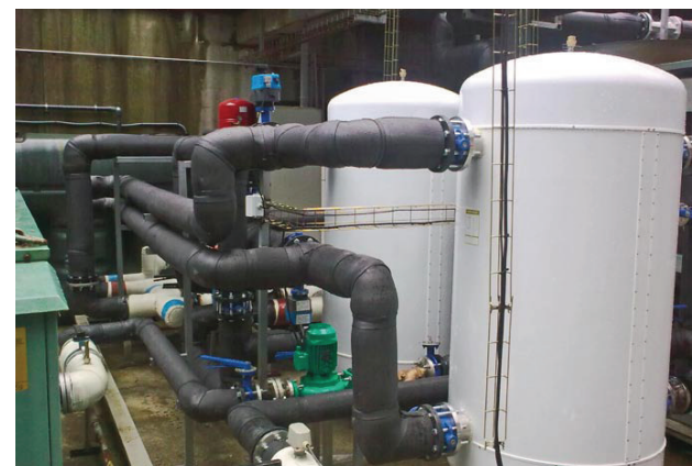
■ Vista de la sala técnica.
