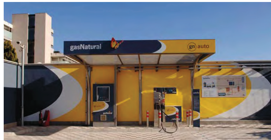
Estación de servicio.
